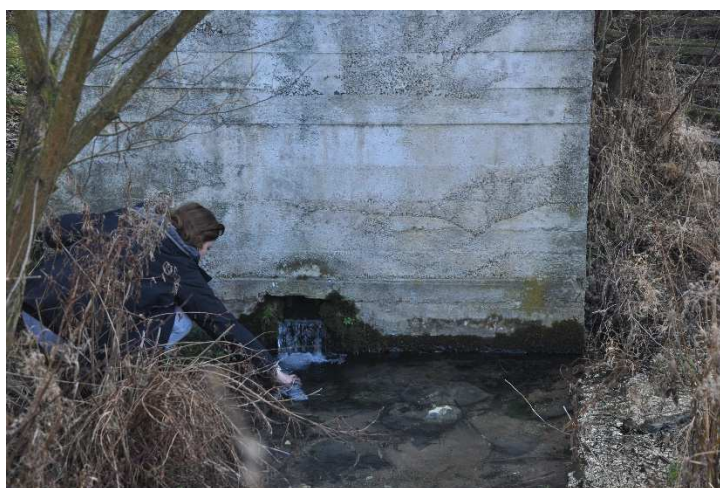
Slika 6.5. Kaptaza na subtermalnom izvoru u Suvom Dolu (foto: M. Kličković)
