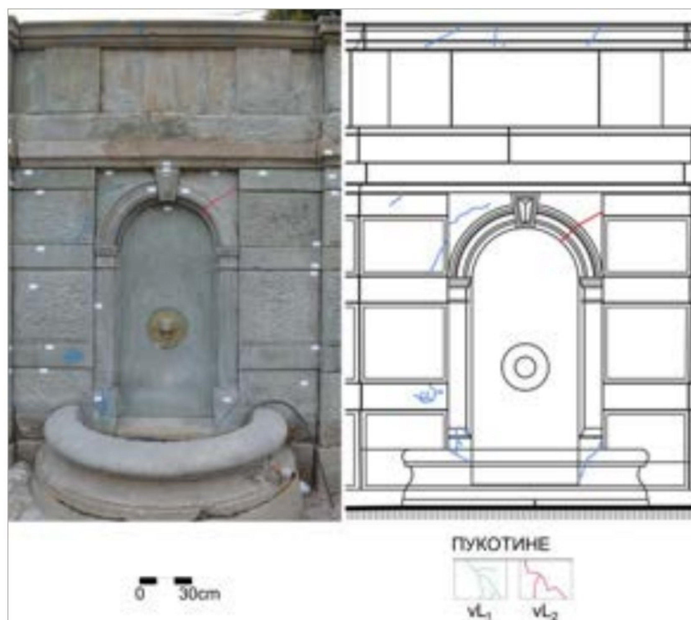
Слика 49. Пукотине: фотографија и графички приказ мапирања
