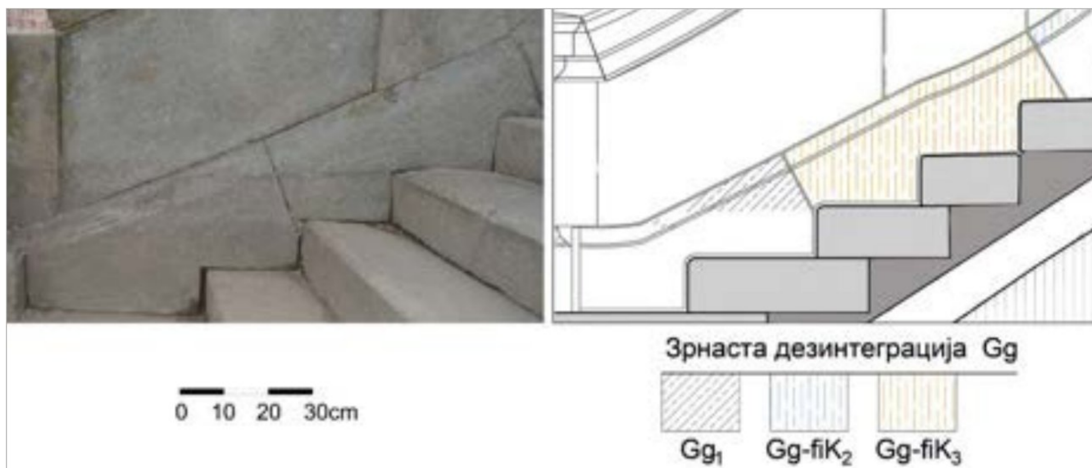
Слика 44. Зрнаста дезинтеграција: фотографија и графички приказ мапирања
