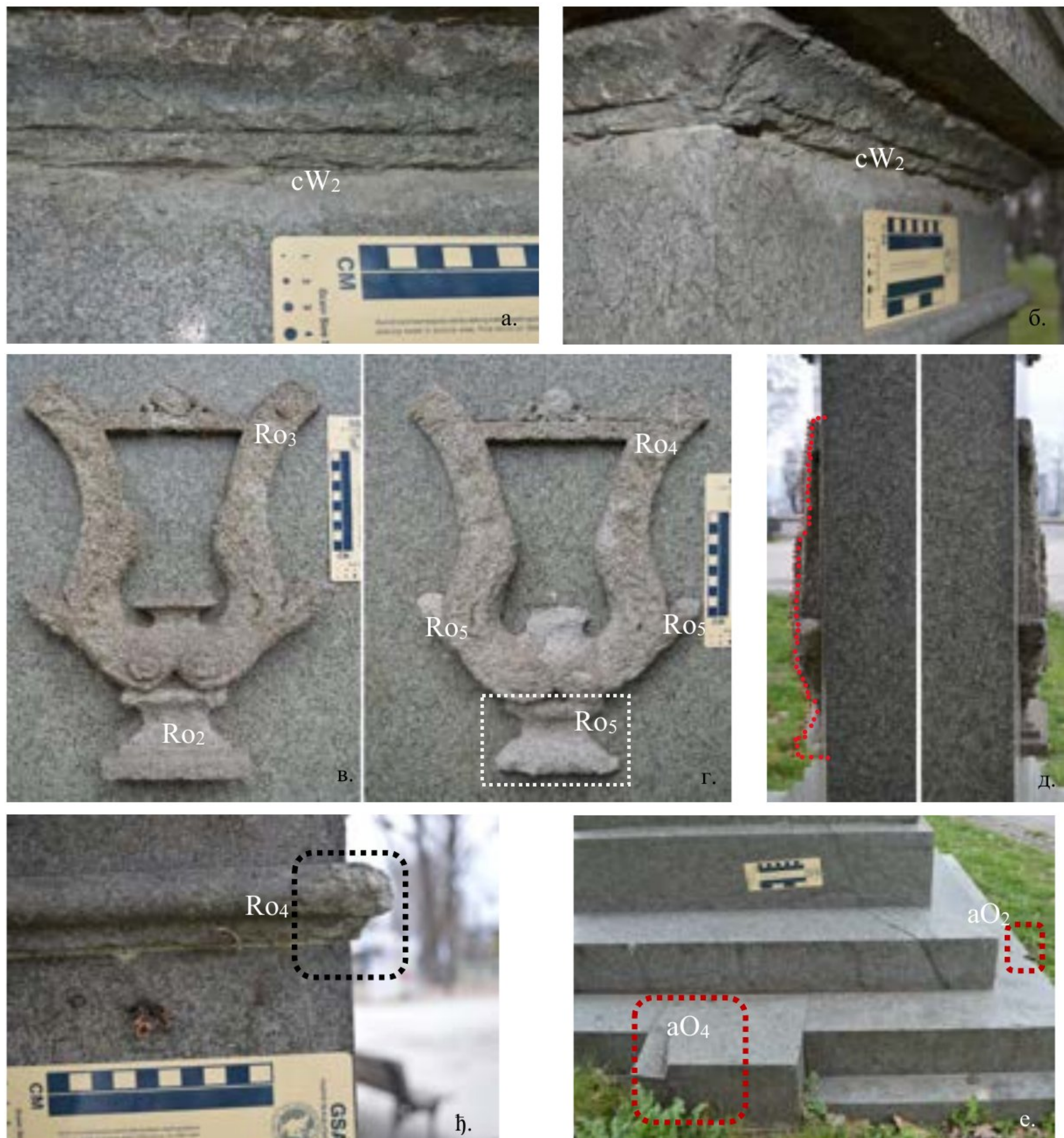
Слика 56. Форме распадања прве групе оштећења – губитак каменог материјала на споменику Ђури Јакшићу; а) дубинско распадање на северној страни споменика; б) дубинско распадање на источној страни споменика; в) рељефно распадање лире на северној страни споменика; г) рељефно распадање лире на северној страни споменика; д) упоредни приказ рељефа лира у профилу; њ) рељефно распадање - заобљавање угаоног дела
