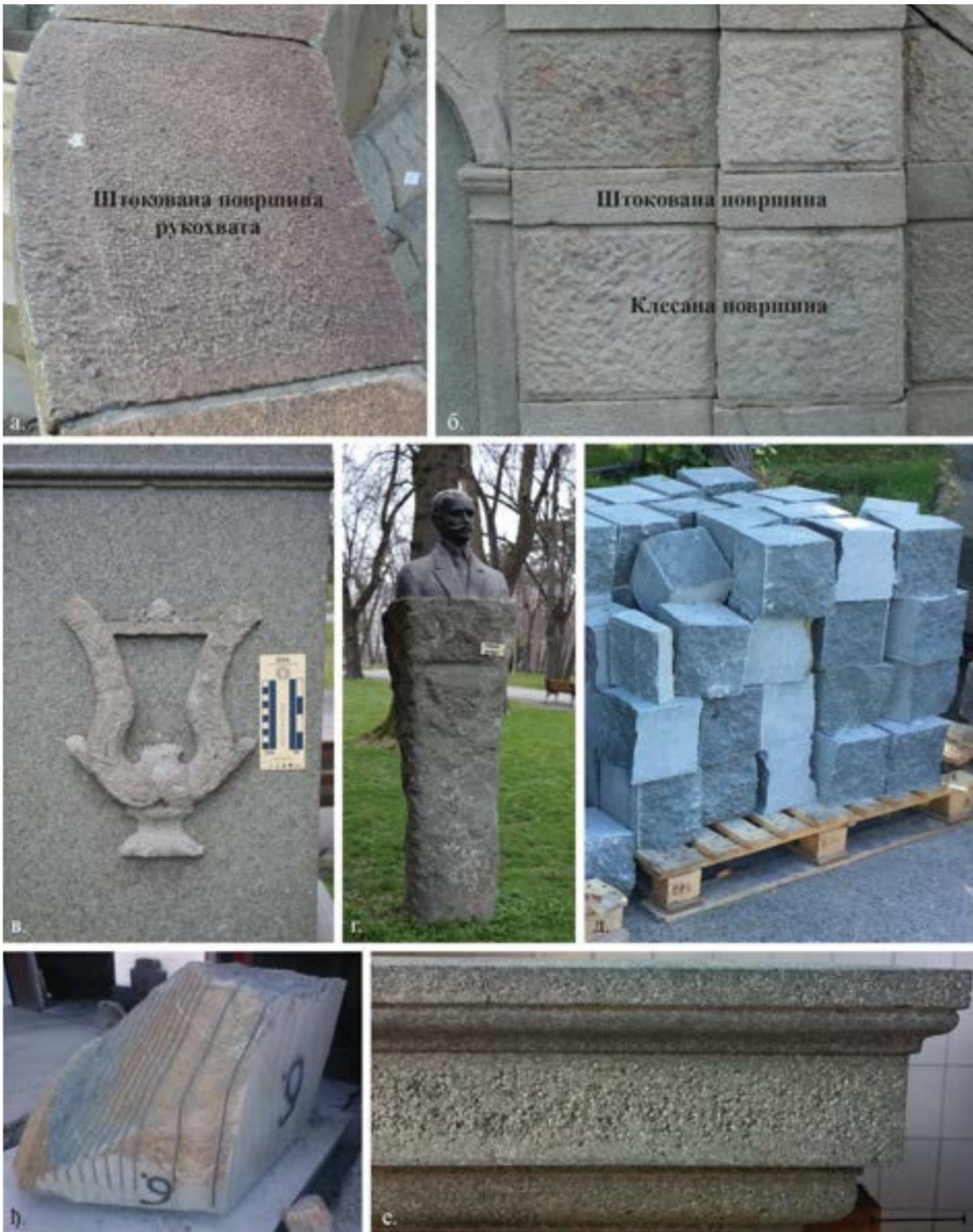
Слика 9. Примери површинске обраде керантита а) штокована површина рукохвата Малог степеништа; б) клесане и штоковане површине предње фасаде Малог степеништа; в) полирана површина, споменик Ђури Јакишићу; г) клесана обрада, споменик Јовану Скерлићу; д) резане и цепане површине калдрме на Малом степеништу; е) гатерисани блок керантита; ж) машински сечен, ручно штокован елемент
