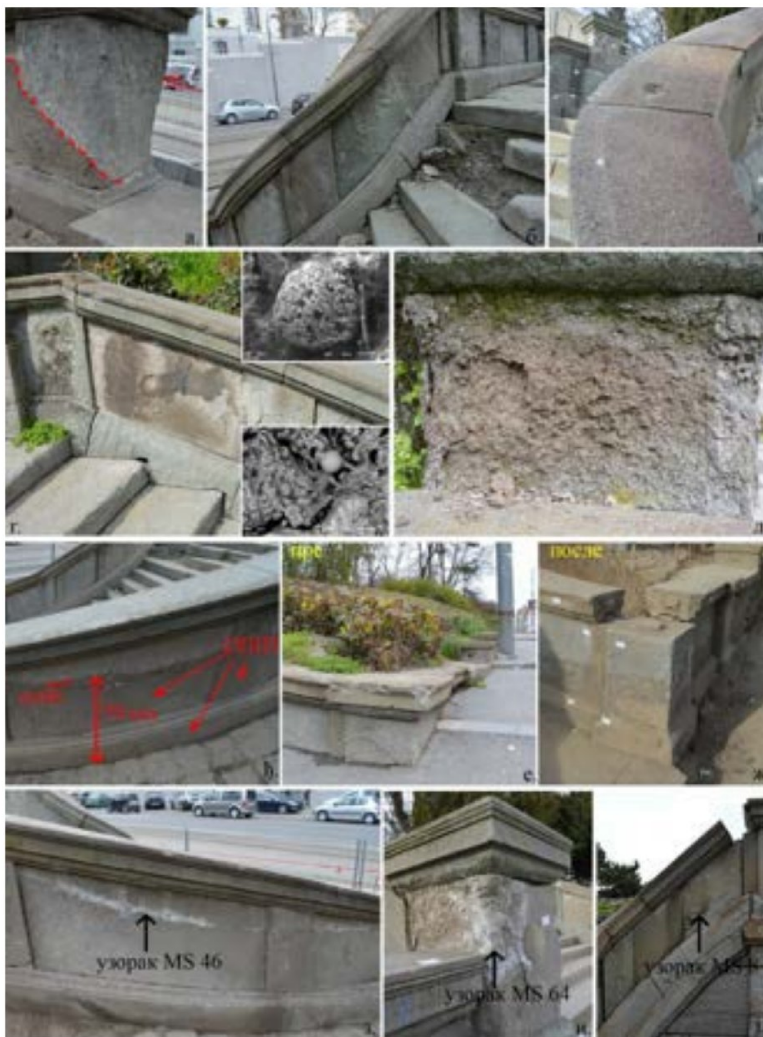
Слика 34. Различити облици оштећења уочени на елементима од керсантита: а) дубинско распадање праћено љуспањем и зрнастом дезинтеграцијом; б) рељефно заобљавање профилисаних делова оgrade и комадасто распадање степеница; в) патина богата гвожђем на рукохватима; г) заобљене ивице степеница и одвајање црне коре састављене од прашине, гипса, угљеника (порозних) и олова (компактних) сфероидних честица; д) интензивно љуспање површине камена; е) приказ дубине затрпане зоне са наслагама соли на граници и очуваним профилима у доњем делу и оригиналном штокованом примарном површином (ОШП); е) камени елементи обложени слојевима асфалта; ж) откривени камени делови након уклањања асфалтних слојева; з) контактна зона (означена солима) између укопаних делова каменних блокова и делова изложених атмосферским утицајима; и) ефлоресценција (исољавање) на оштећеној каменој површини; ј) остатак површинске коре и браонкасте коре обogaћене гвожђем
