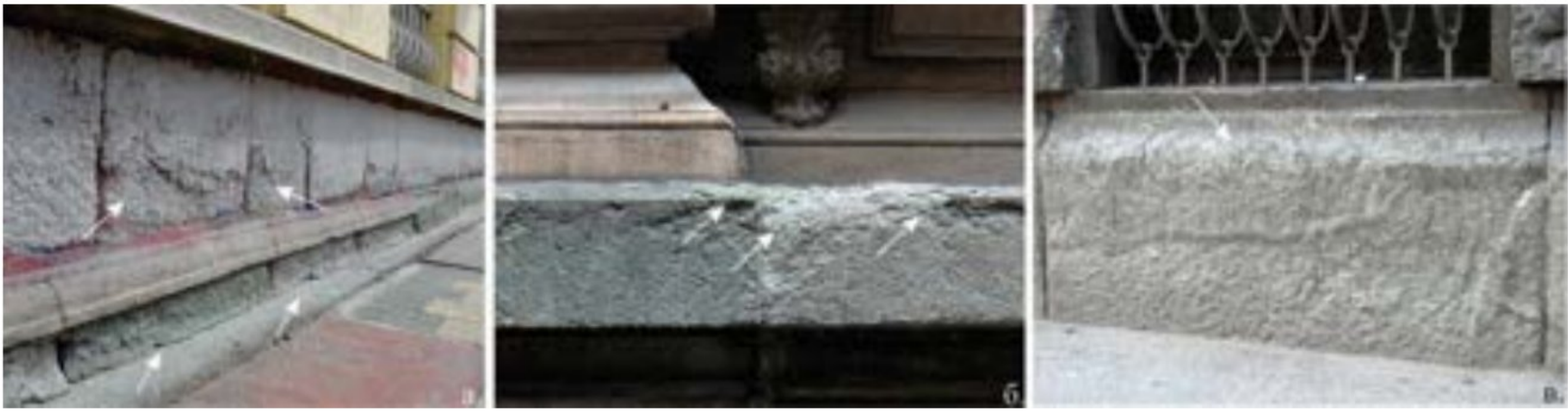
Слика 120. Делови објеката где дужи задржавање воде условљава интензивну физичку деградацију; а) љускање и љуспање керсантита у сокли зграде Класне лутрије – фасада ка Васиной улици; б) љуспање и рељефно распадање керсантита уграђених у венац на главној фасади зграде Народног музеја; в) дубинско распадање и рељефно заобљавање површине керсантита – фасада Народног музеја ка Васиной улици
