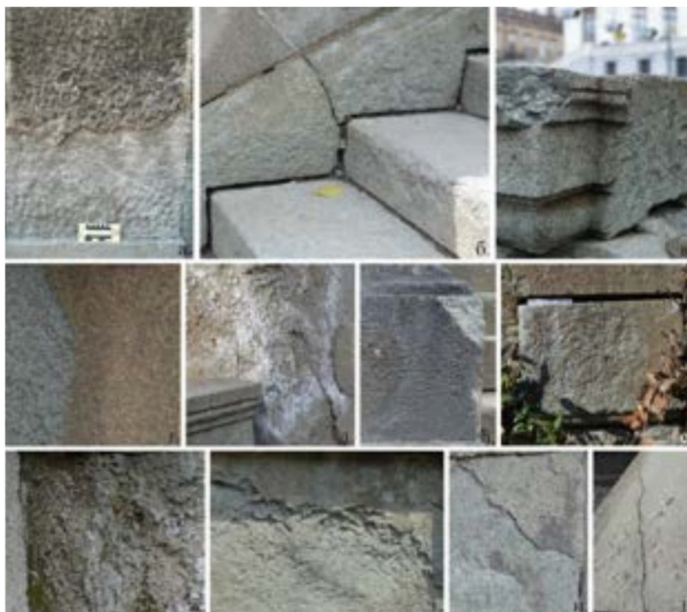
Слика 12. Примери различитих форми распадања: а) дубинско распадање; б) рељефно заобљавање; в) комадасто распадање г) деколорација у виду обојења; д) наслаге соли; ђ) црне коре; е) биолошка колонизација; ж) зрнаста дезинтеграција; з) вишеструко љуспање; и) љускање; ј) пукотине
