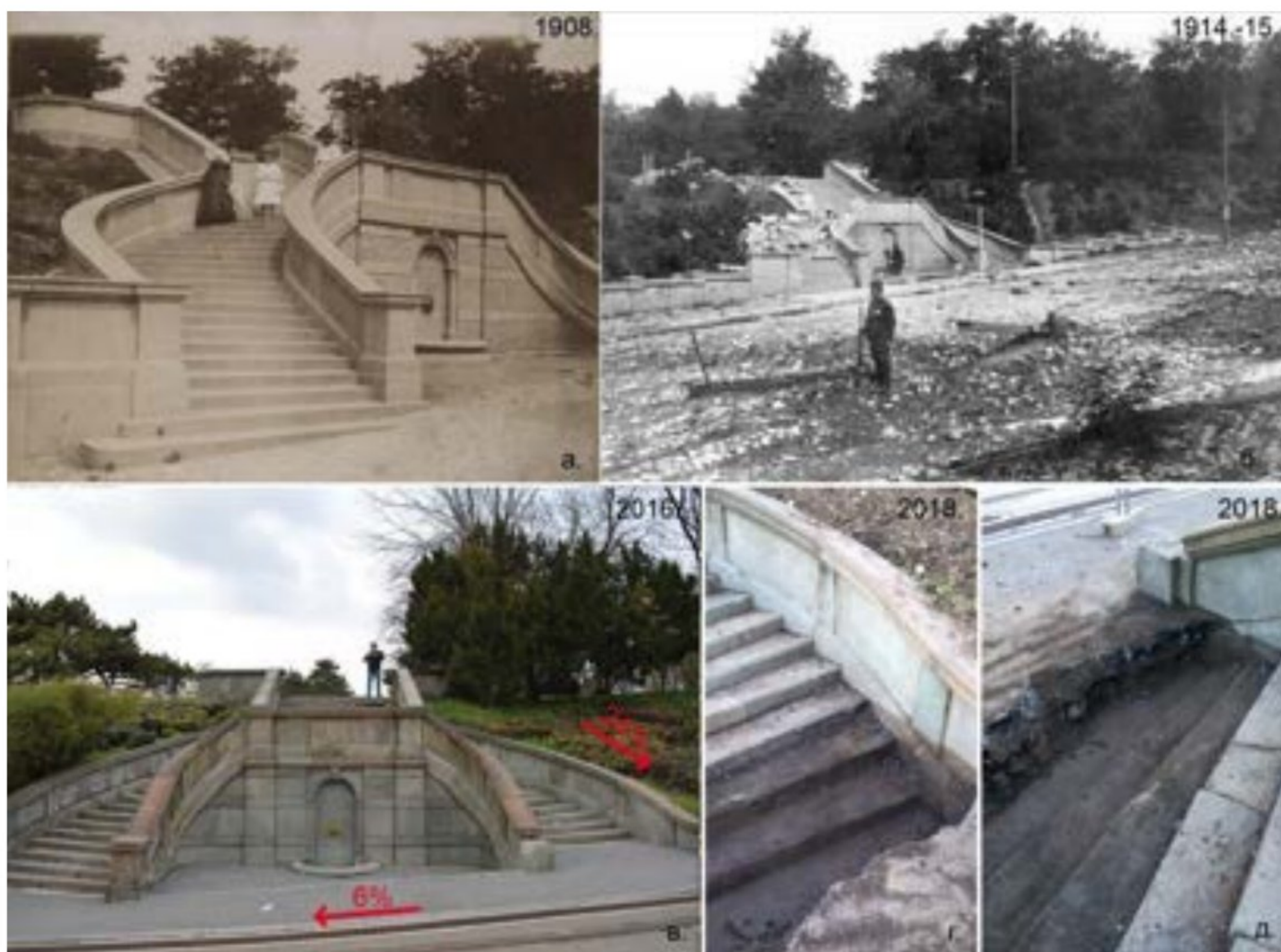
Слика 5. Хронолошки изглед објекта Мало степениште; а) изглед након изградње 1908. године; б) Мало степениште у току Првог светског рата 1914-1915. године; в) Мало степениште, фронтални изглед 2016. године; г) откривена газашта која су била испод нивоа тротоара; д) попречни пресек слојева повлате затрпаних степеника (а) и б) извор документација Завода за заштиту споменика културе града Београда, в), г), д), извор аутор)
