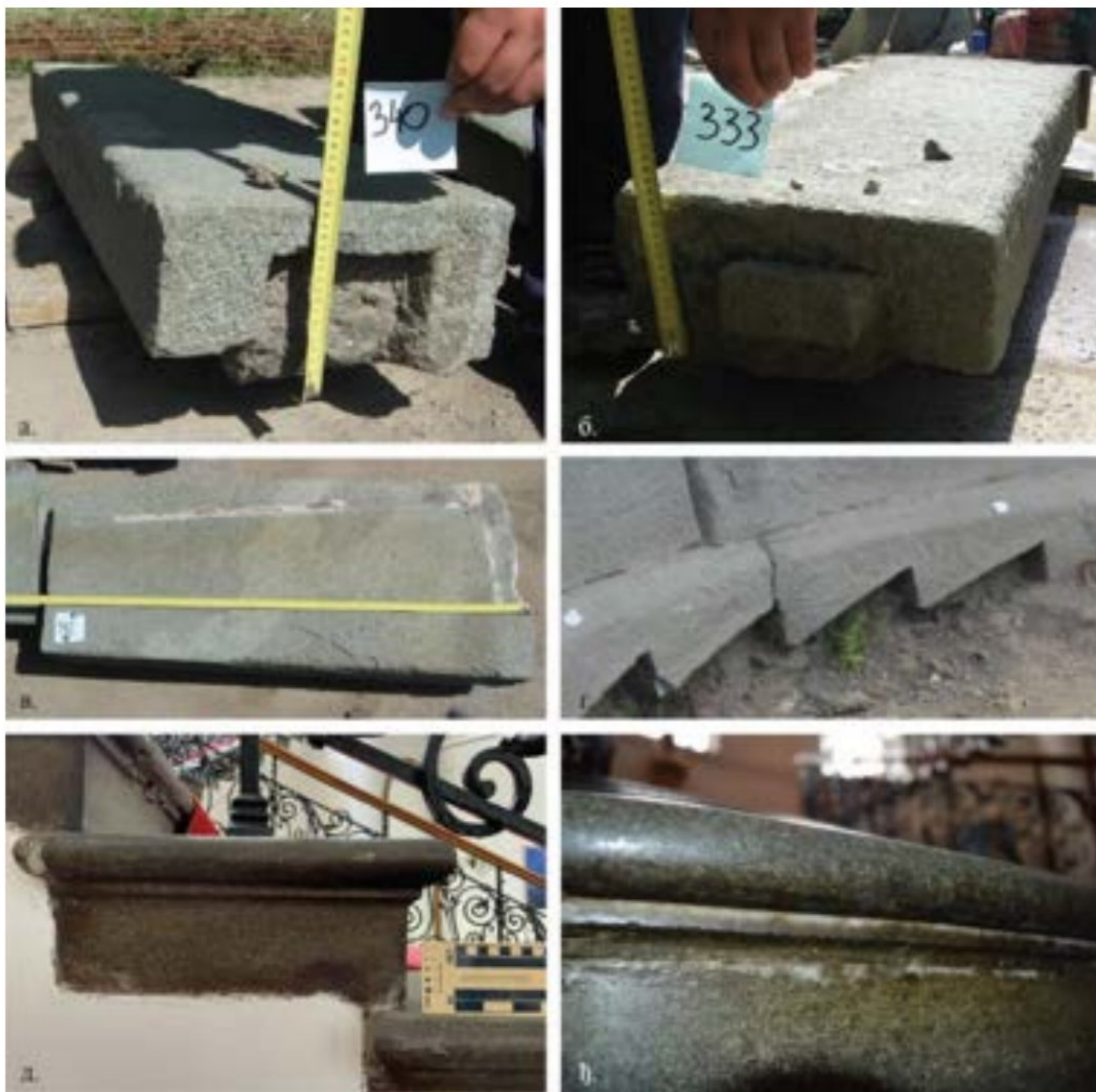
Слика 10. Примери детаља градње степеништа од камена а-б) профил степеника са системом спајања на перо и жљеб; в) горња површина степеника са површином која је уметана у оградни образ степенишне ограде; г) део базе ограде степеништа (образима подупрто степениште, Несторовић, 1927); д) профилисани степеници централног степеништа зграда Класне лутрије; љ) детаљ профила (окапнице), зграда Класне лутрије
