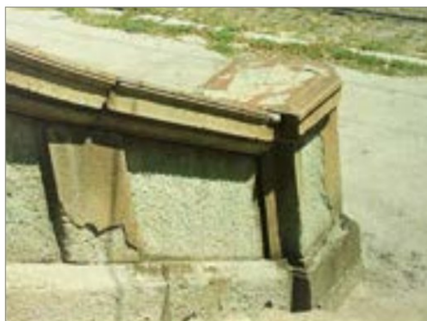
Слика 127. Интензивно љускање штоковане површинске зоне керсантита без или са делимично очуваним остацима примарне површине
