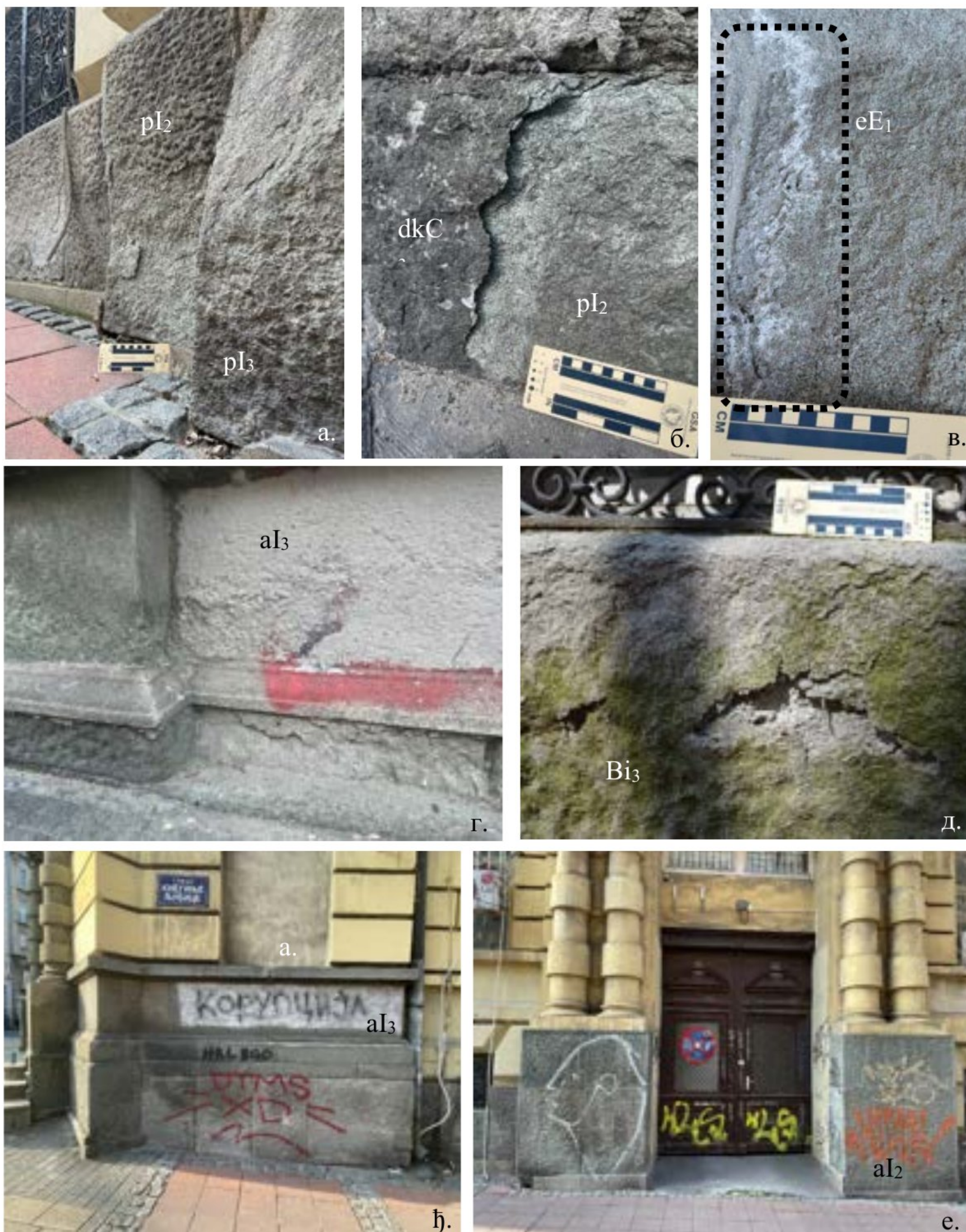
Слика 71. Форме распадања друге групе оштећења – деколорација/наслаге на споменику културе Згради класне лутрије; а) запрљаност услед наслага нечистоћа из атмосфере; б) црне коре; в) исољавање; г) запрљаност услед антропогеног утицаја-фарбање површине камена; д) биолошка колонизација нижим биљкама; ђ-е) запрљаност услед антропогеног утицаја-вандализмом - исписивањем графита
