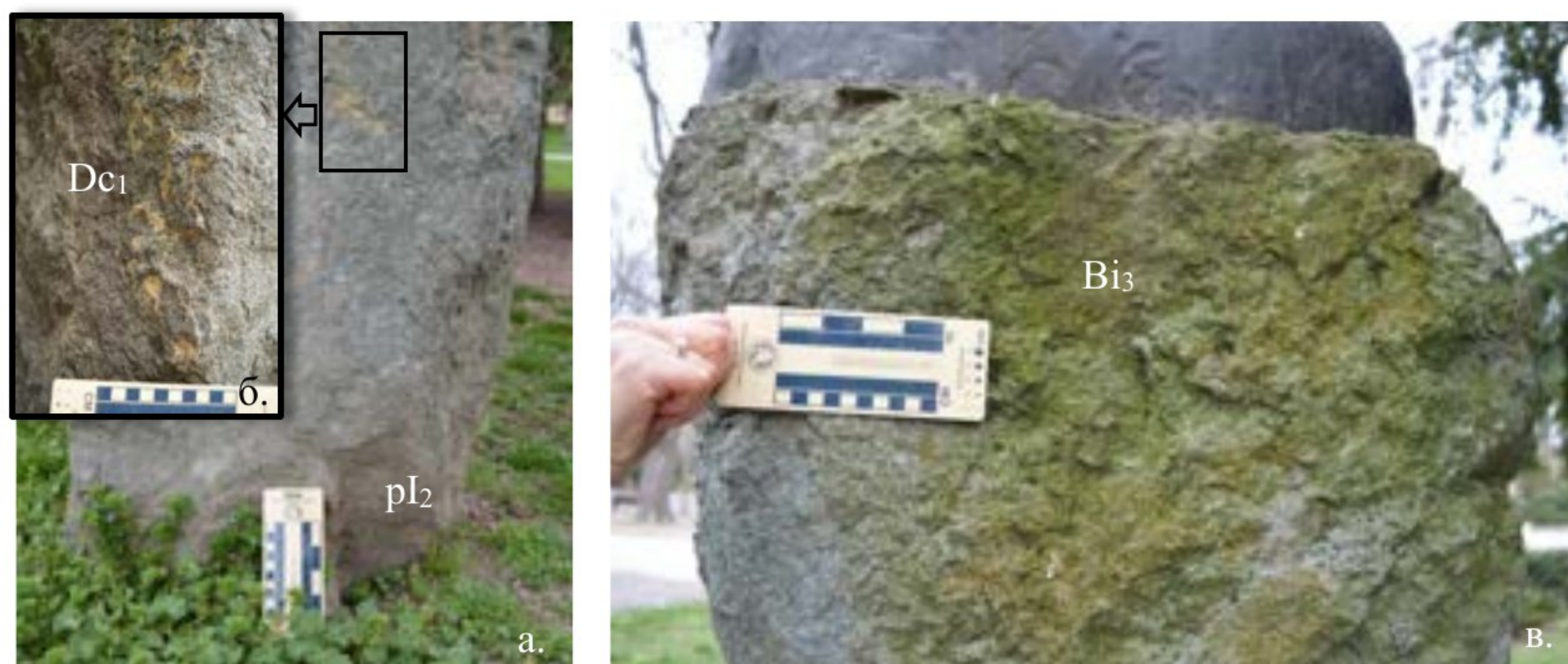
Слика 63. Форме распадања друге групе оштећења – деколорација/наслаге на споменику Јовану Скерлићу; а) запрљаност услед наслага нечистоћа; б) деколорација-хроматска промена боје калцитних жица в) микробиолошка колонизација;
