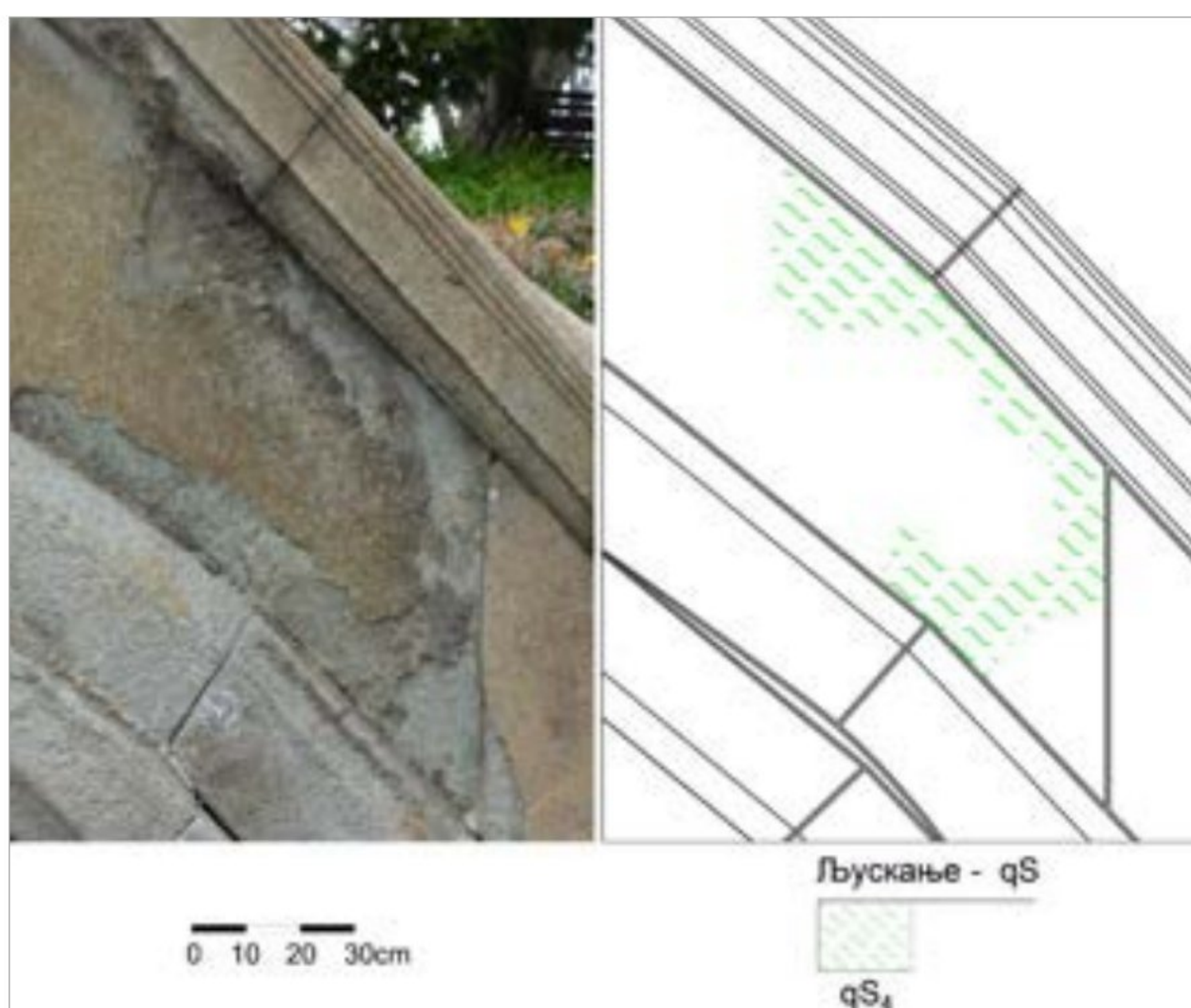
Слика 46. Лускање: фотографија и графички приказ мапирања
