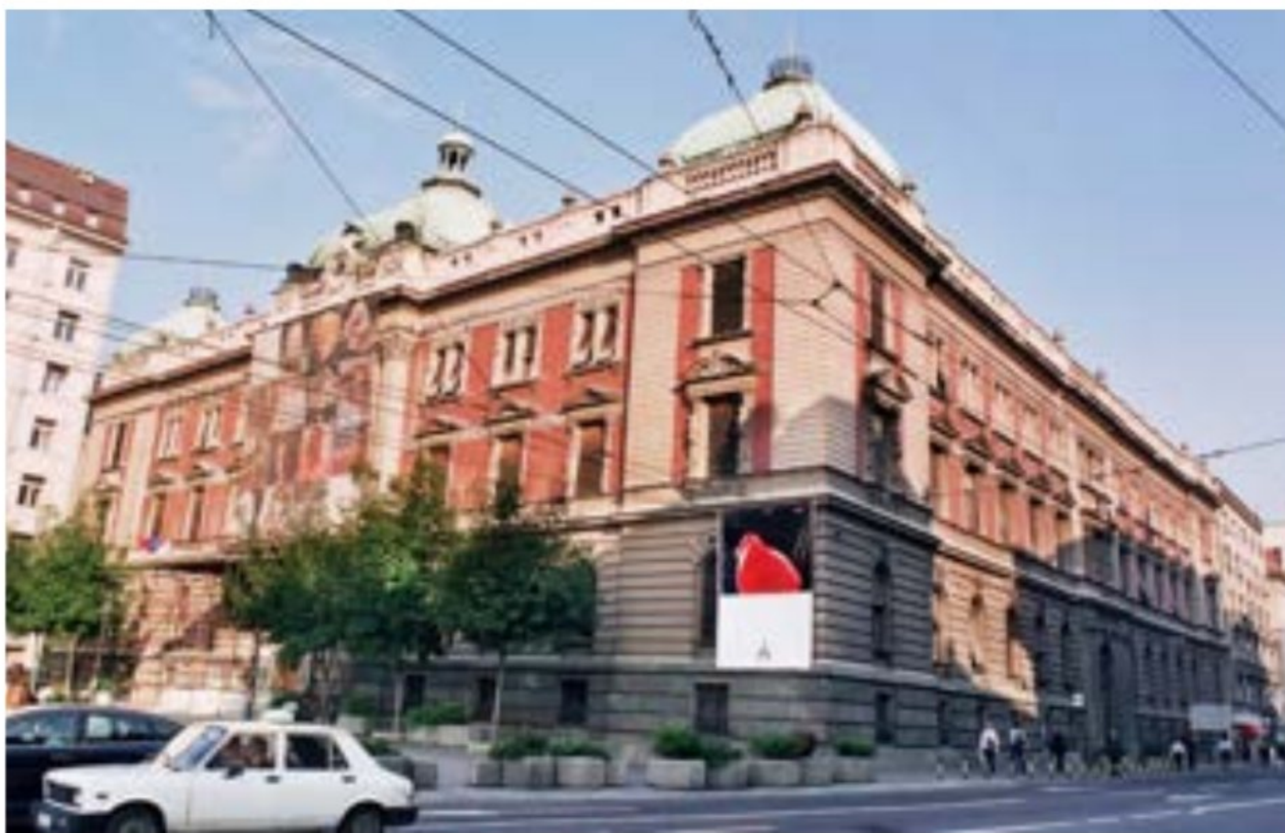
Слика 73. Општи изглед зграде Народног музеја
