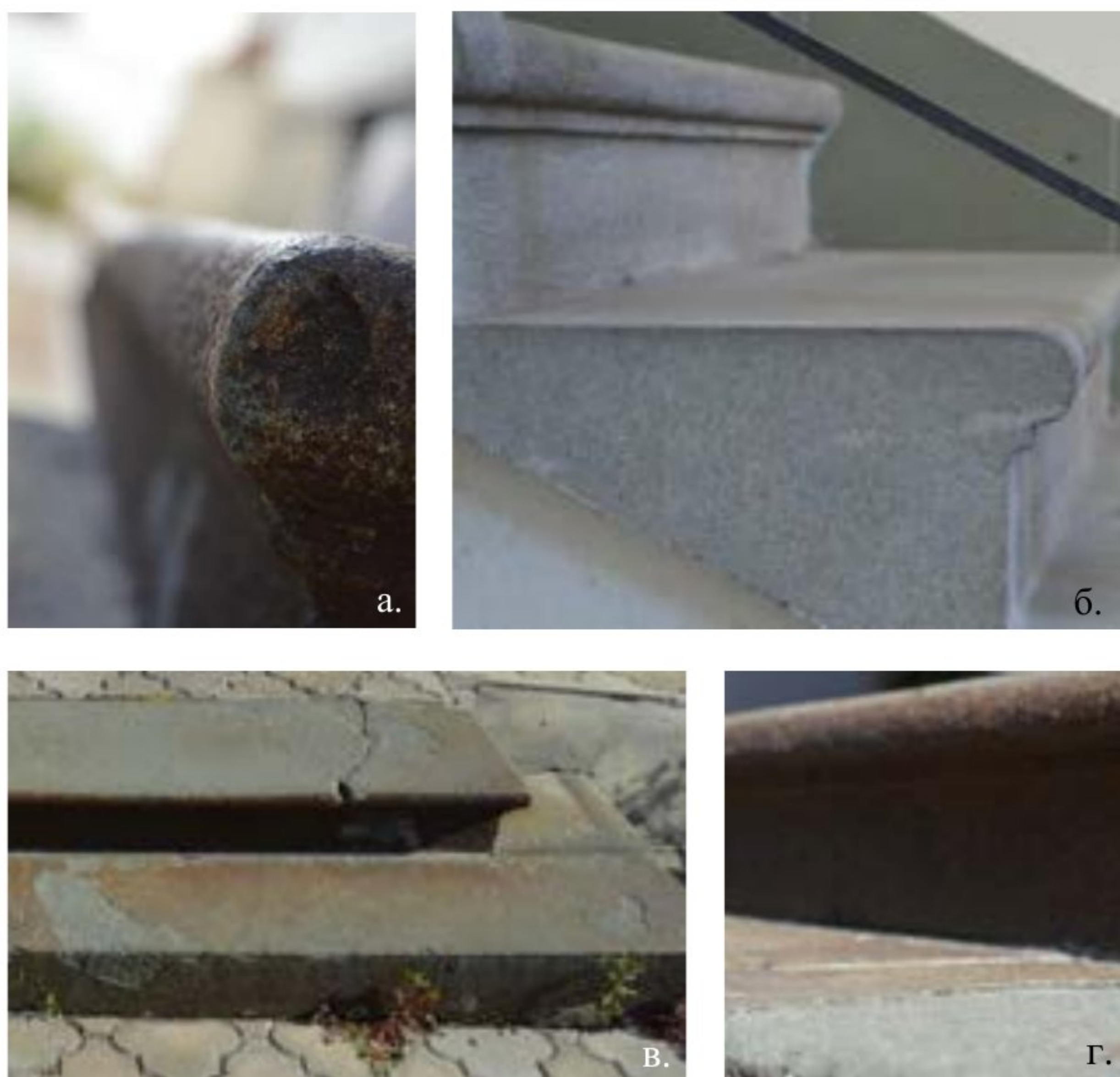
Слика 77. Форме распадања друге групе оштећења – деколорација/наслаге: а) обојење; б) запрљаност; в) колонизација вишим биљкама; г) обојена кора
