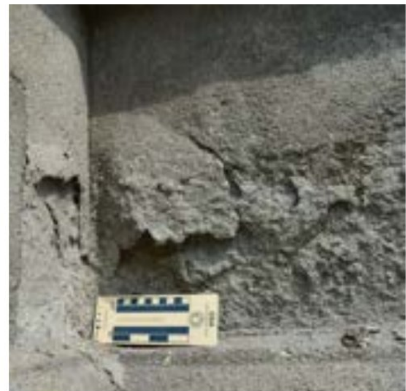
Слика 121. Подклубучавање и одвајање површинске коре керсантита (зграда Класне лутрије)
