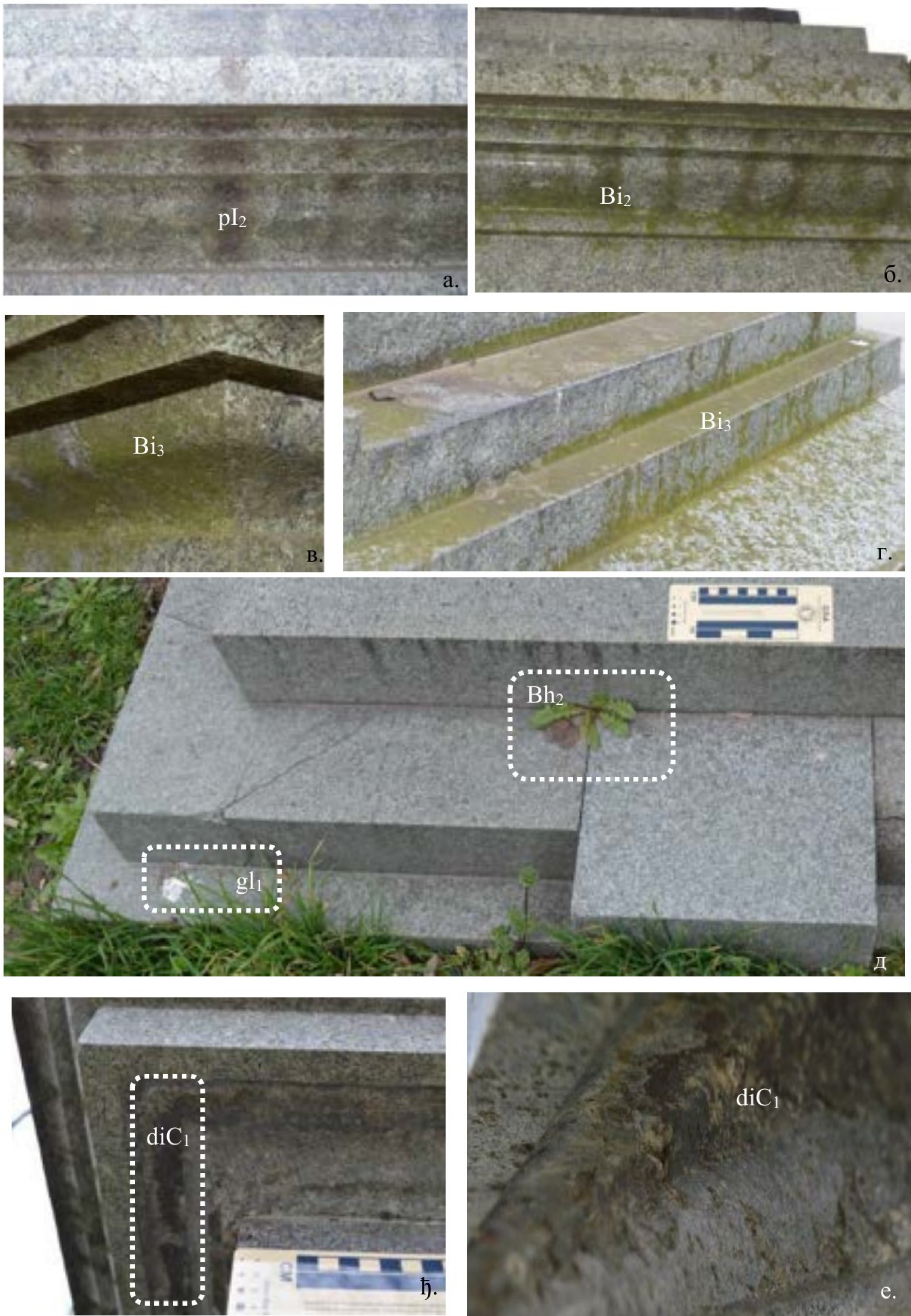
Слика 57. Форме распадања друге групе оштећења – деколорација/наслаге на споменику Ђури Јакшићу; а) запрљаност услед наслага нечистоћа из атмосфере; б-г) микробиолошка колонизација; д) биолошка колонизација вишим биљкама и птичији измет; ж) црна кора развијена на доњим, заклоњеним и хоризонталним горњим површинама капитела; е) детаљ црне коре
