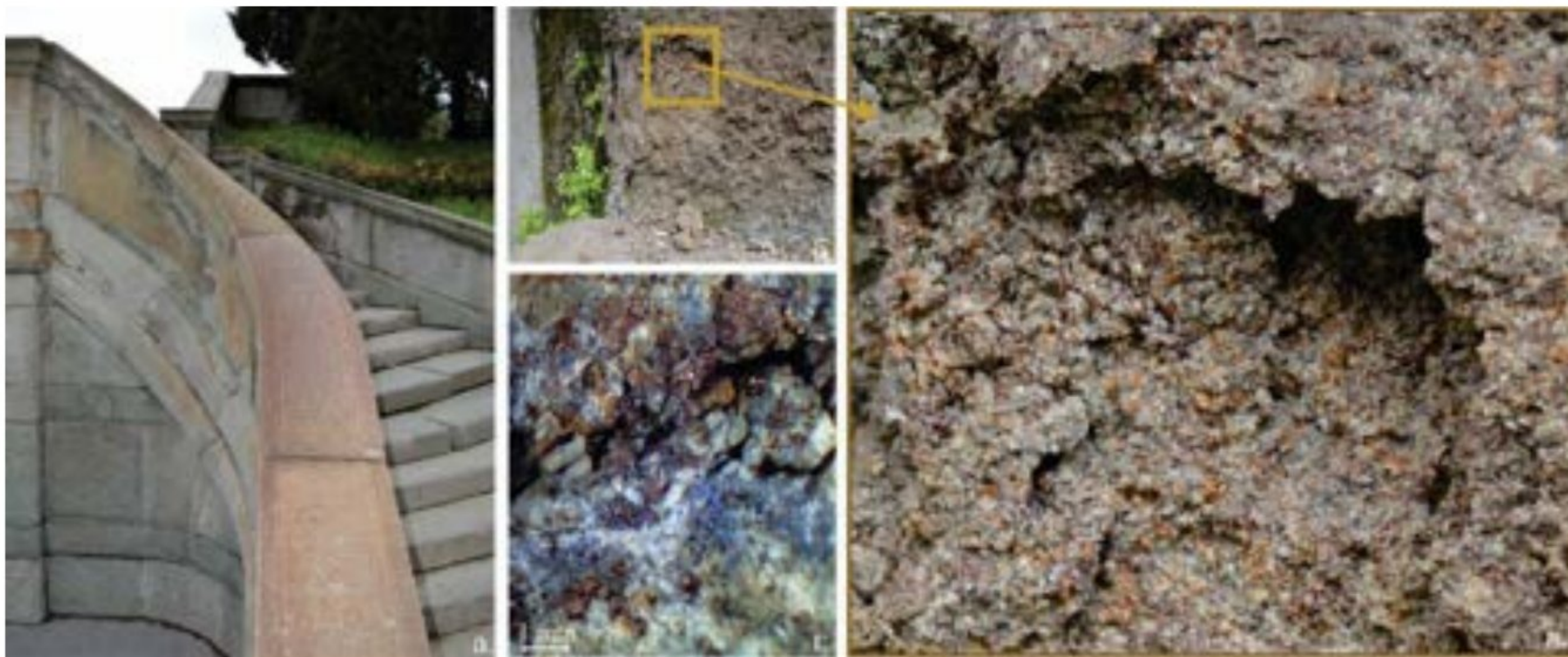
Слика 122. Деколорација површине керсантита уграђеног у Мало степениште; а) црвено-смеђа површинска кора; б) дезинтегрисана површина керсантита в) љуспасто-зрнаста дезинтеграција са израженим оксидима/хидроксидима гвожђа; г) бронзано браон лиске површински дезинтегрисаног биотита са депонованим оксидима/хидроксидима гвожђа по површини, изолованим зрнима фелдспата у пукотини (изглед површине под бинокуларом)
