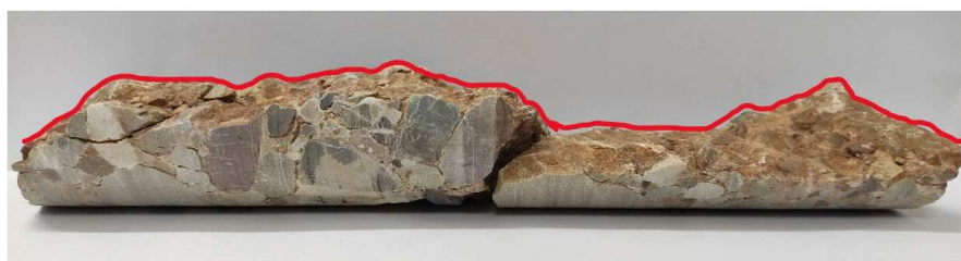
Slika 24. Hrapavost zida reprezentativne pukotine (dužina pukotine 30 cm) (foto: D. Marjanović)
