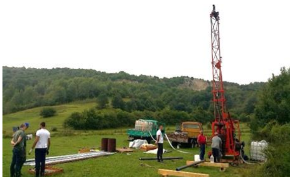
Слика 28. Бушење истражних бушотина на пројектованим локацијама Церничког поља (Сорајић & Милановић (2018) )
