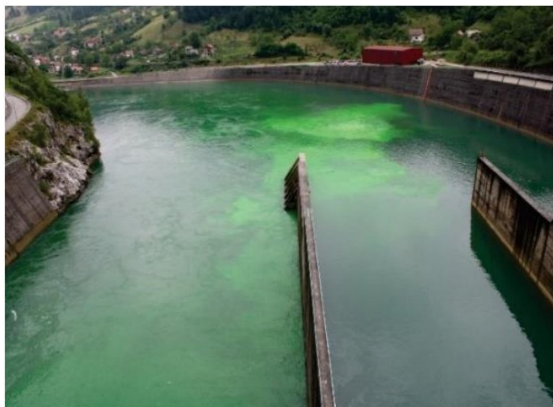
Opit bojenja procurivanja ispod brane Višegrad (B&H) Tracer test, Višegrad dam (B&H)
