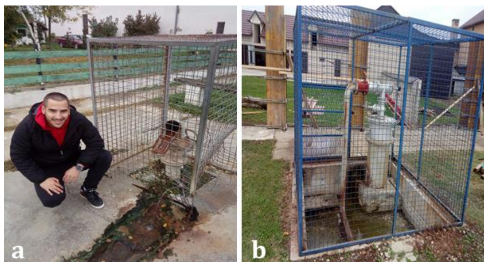
Slika 1.35 Gornji delovi konstrukcijabunara „BMe-1“ (Metković) (a) i „BB-1“ (Bogatić)(b)
