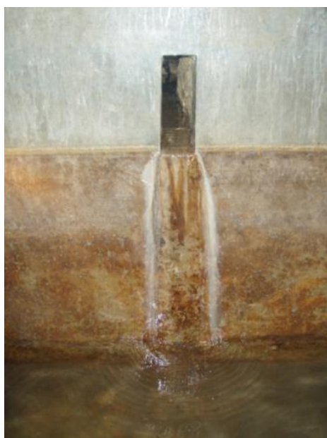
Слика 4.4. Поглед на отвор – „барбакану“, унутрашњост каптаже (фото: Јемцов. И; 2010)
