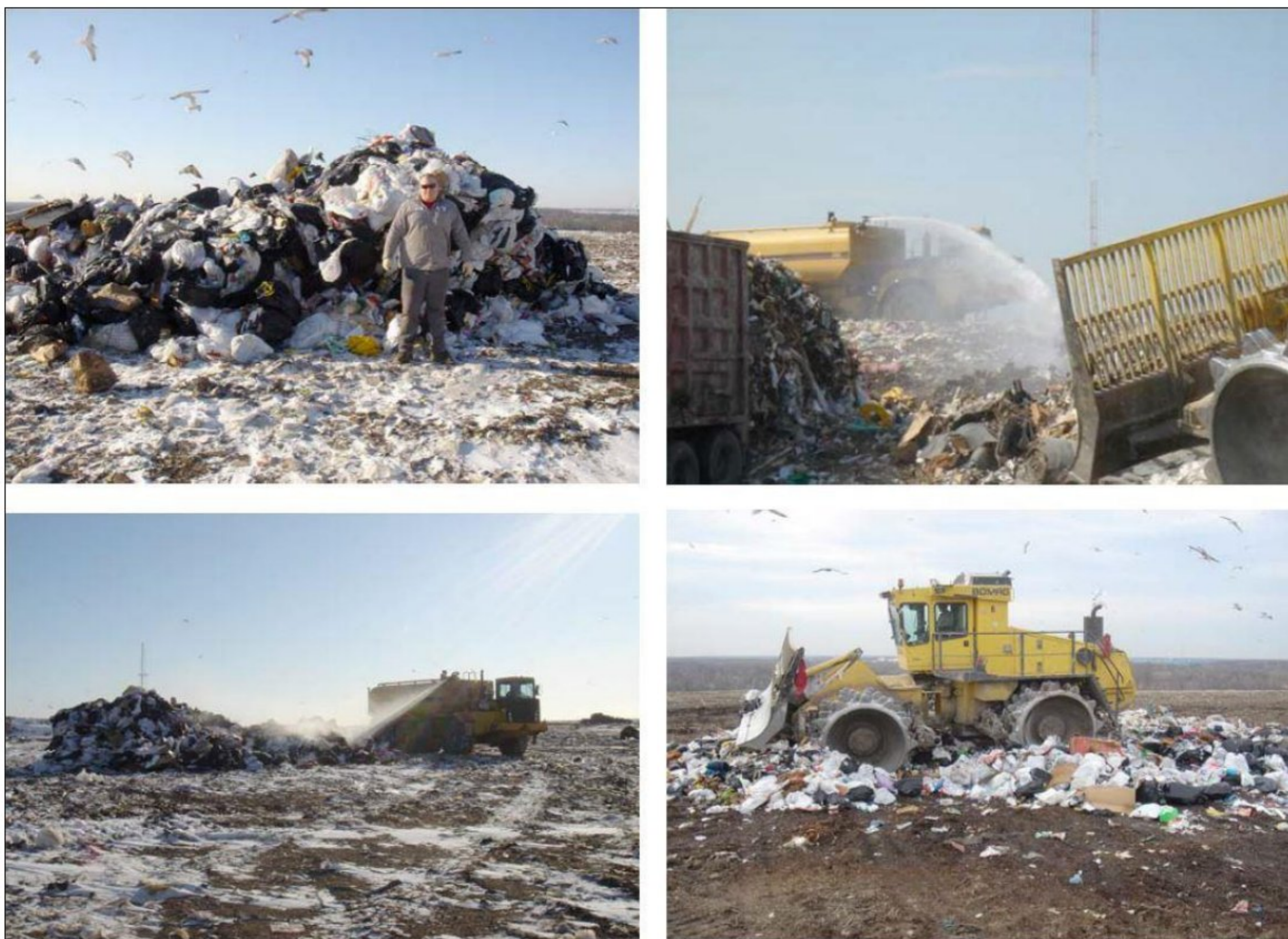
Slika 2.31: Prikaz odlaganja komunalnog otpada na probno polje, dodavanje vode i zbijanje (Hanson i sar. 2010)
