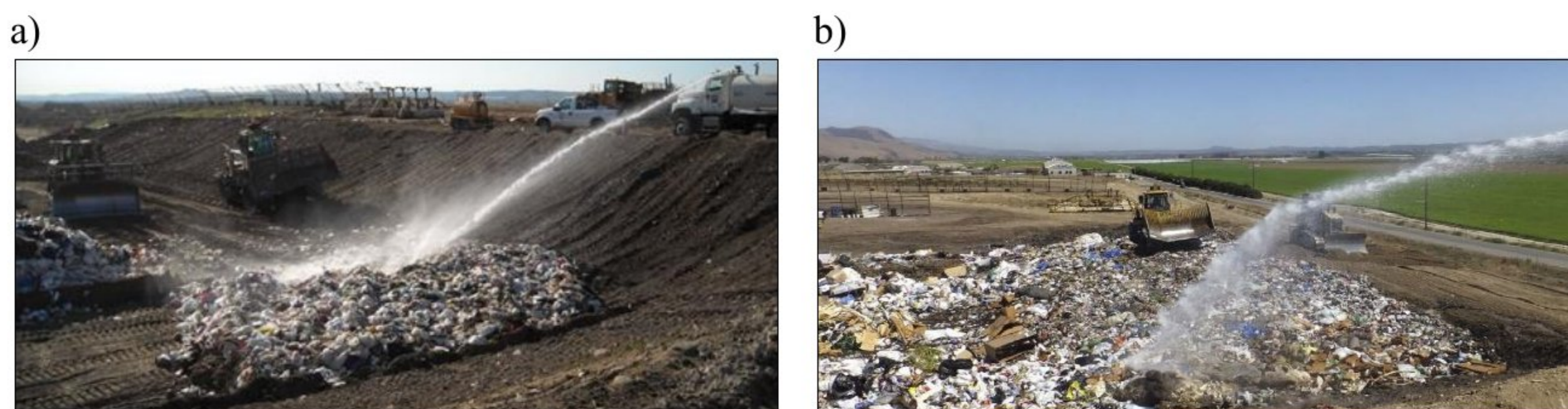
Slika 2.33: Provlažavanje otpada: a) probno polje i b) aktivna deponija (Cox i sar., 2015)
