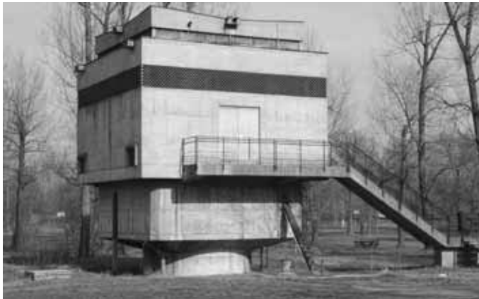
Slika 10: Jedan od bunara sa horizontalnim drenovima Beogradskog izvorišta na Adi ciganliji
