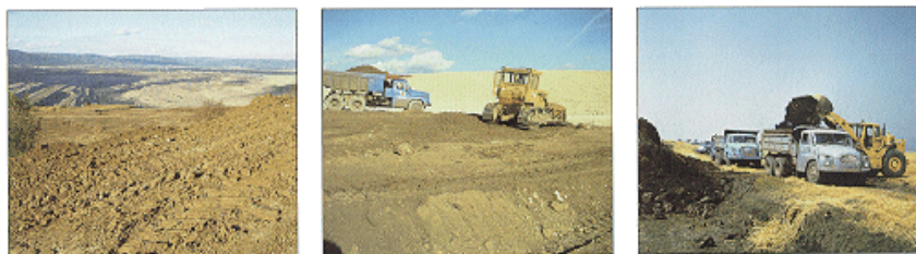
Слика 1.29. - Селективно откопавање и техничка рекултивација
