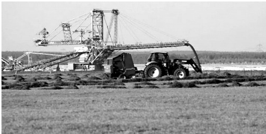
Слика 1.3. - Убрзана рекултивација Welzov-Sud
